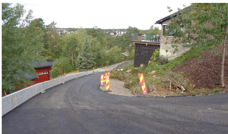
Midlertidig omkjøringsvei mellom Bratthammeren og Fagerliveien
