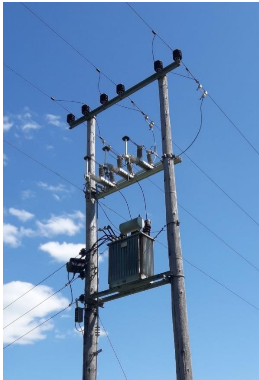
Figur 1: Eksempel på farlig utformet strømstolpe for hubro, her med piggisolatorer, ståltravers, kabler ned til transformator med uisolerte deler, også i åpent område hvor hubroen jakter.
