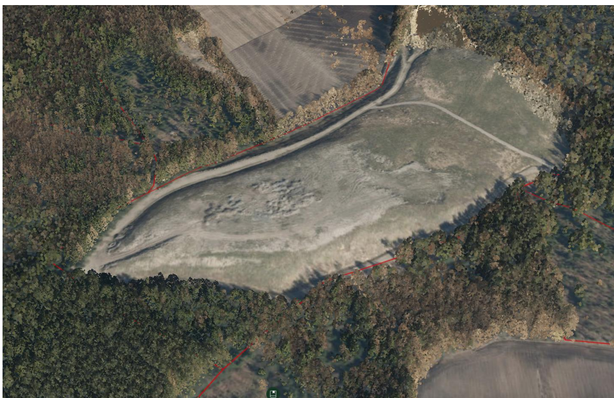
Figur 0-1. Dagens situasjon Forsetlundgropa som er et avsluttet massedeponi for rene masser.
