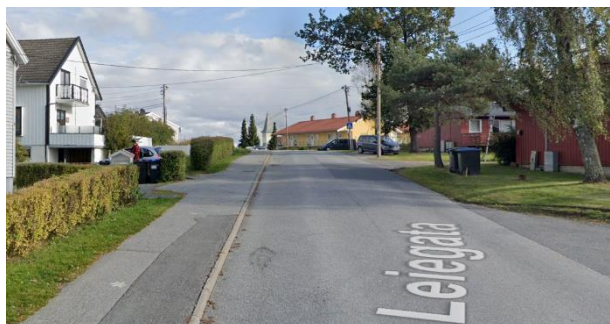
Utsnitt fra planområdet, sett i retning mot øst. Bildet er tatt rett øst for rundkjøring i Rolvsøyveien. Hentet fra google.com/maps .
