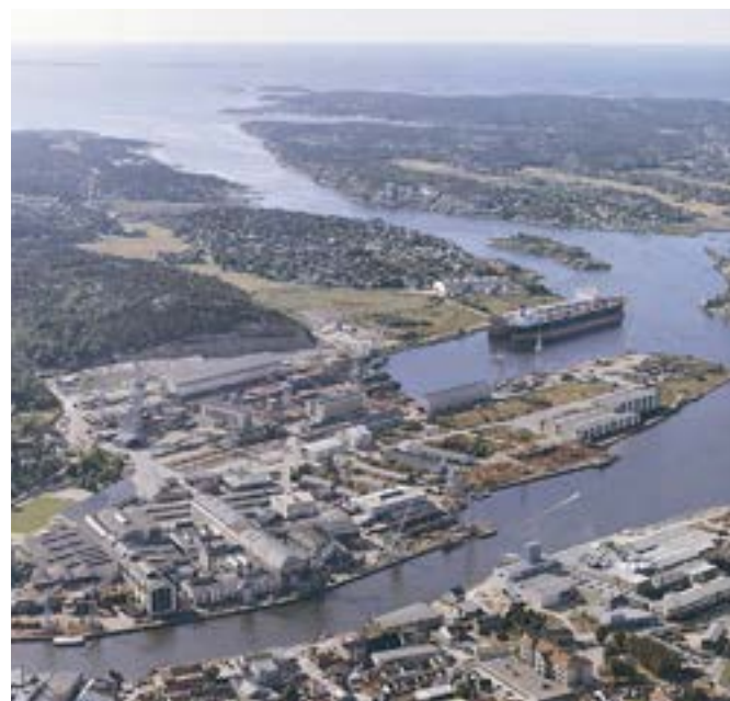
Illustrasjon 10: FMV under full drift, hvor man ser det industrielle landskapet preget av store haller og flater, lange kanter med baner for høye kraner, helt ut til Glombo.
