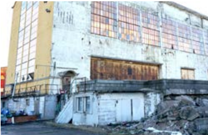
Illustrasjon 31: Dagens situasjon er preget av spranget mellom øvre og nedre nivå av sveisehallen, med asfalt, støpte betongstrukturer og grunnfjell som dominerende materialer. Situasjonen krever opprydding og og gjennomtenkte tiltak for utforming.
