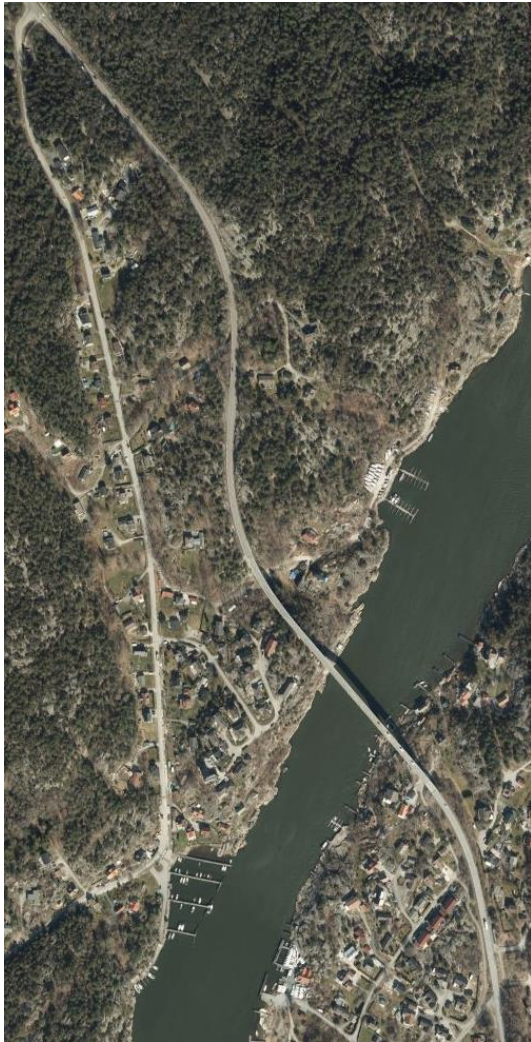
Figur 8-59 Kartutsnittet viser dagens Kjøkøysund bru og omkringliggende områder. (Kilde: Norgebilder.no)
