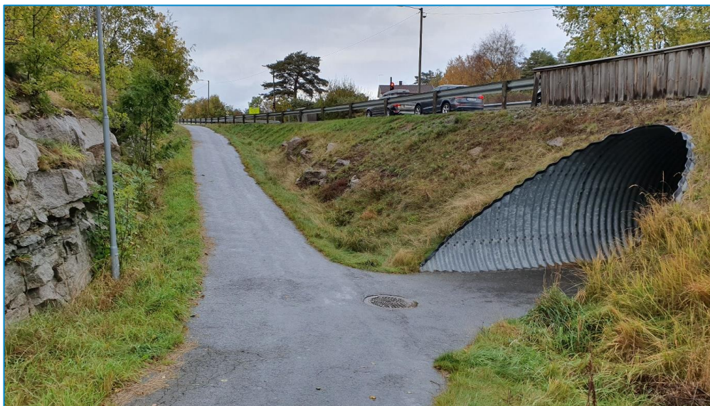
Figur 8-5 Gang- og sykkelundergang mellom Kjerreveien og Nordre Rekin (Foto: Sweco Norge AS)
