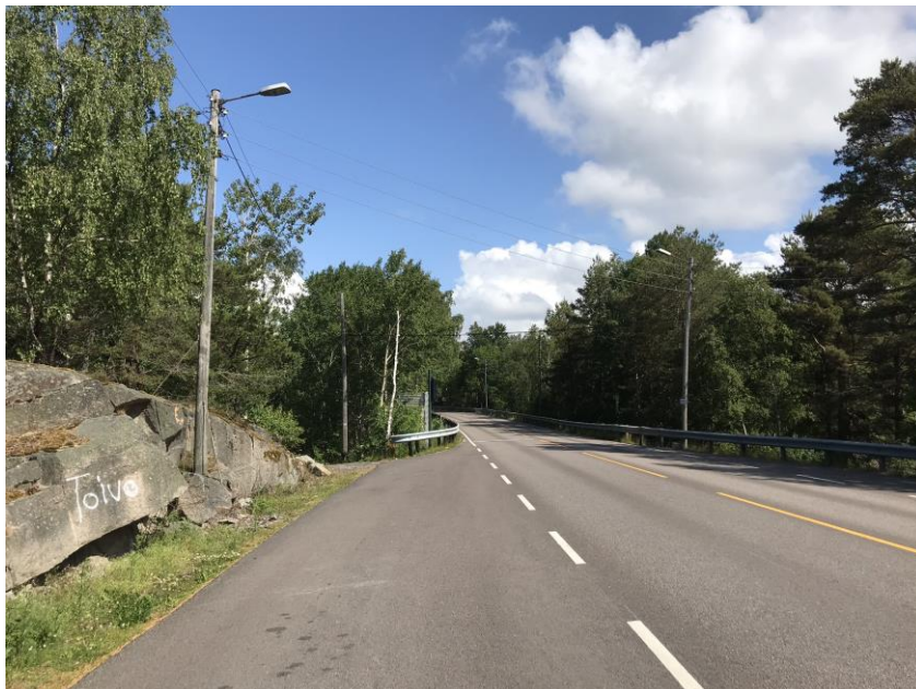
Figur 8-66 Kråkerøy v/bussholdeplasser sett nordover. (Foto: Sweco Norge AS)
