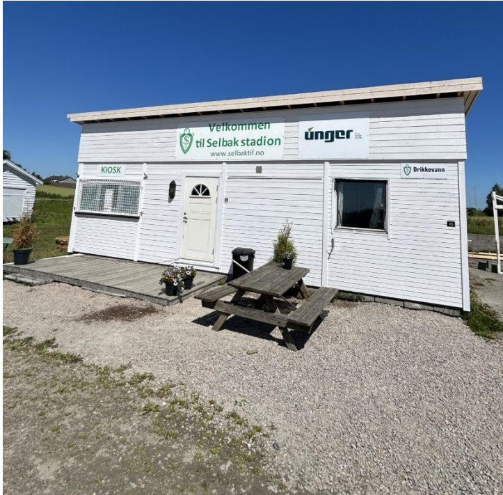
Bilde av: Nytt tak på garderobe/lager/kiosk.
