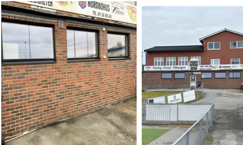
Bilder: Nye varmepumper i brytehallen, skifte av tak og vinduer på klubbhuset.
