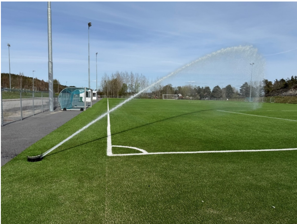
Bilde: Nytt vanningsanlegg på kunstgressbanen i Trondalen.
