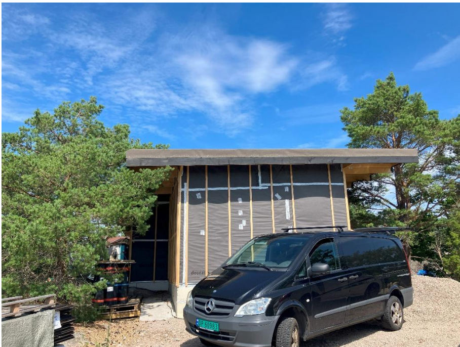
Figur 4: Bilde av påbegynt enebolig, sett fra syd. Som man kan se, har tiltakshaver valgt å beholde vegetasjonen rundt huset.
