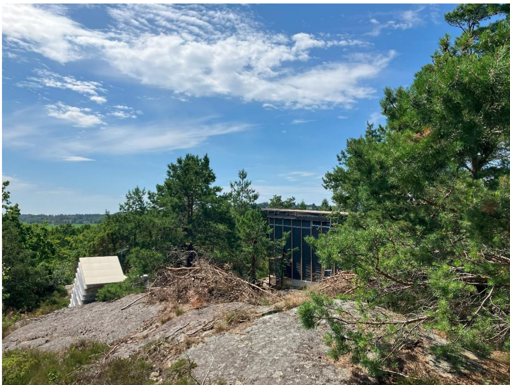
Figur 7: Bilde som viser påbegynt hus (tatt 30.06.2025). Som man kan se, bidrar eksisterende vegetasjon til å skjerme huset.
