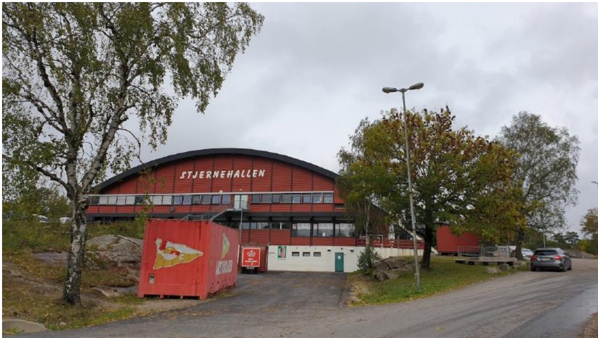
Figur 19 Stjernehallen sett fra sør med noen av de større trærne. Deriblant en stor ask (EN) til høyre i bildet.
