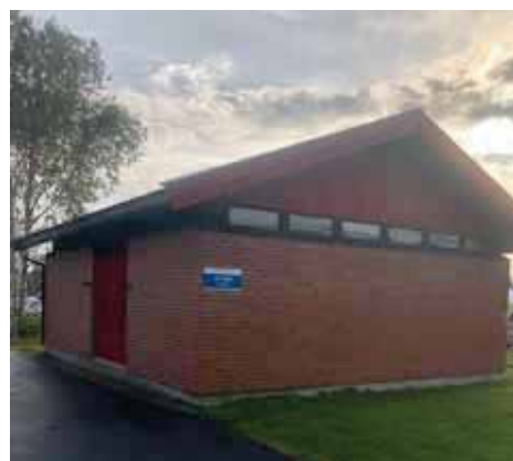
Figur 13. Smertu avløpspumpestasjon. Mottar avløp fra sentrum og Kråkerøy nord.
