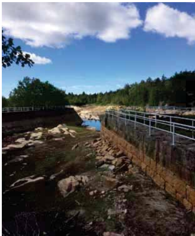
Figur 7. Trondalsdammene. Her ser man den gamle murdammen og den nedtappede platedammen som skal rives.
