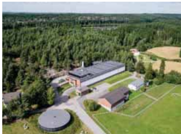
Figur 16. Vannverket på Høyfjell
