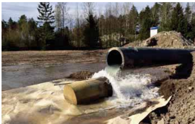
Figur 12. Kjøring av renseplugg i ringledning før denne settes i drift. Ved Kvernhuset 2015.
