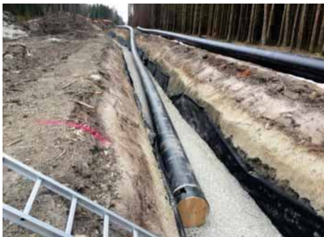
Ledningsgrøft ved Høyfjell.
