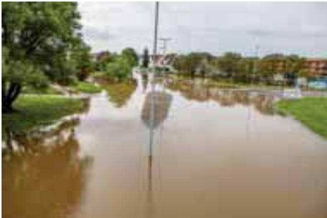
Bildene viser oversvømmelser i Holmegata etter stort nedbør (14.8.2008 og 1.9.2019)
