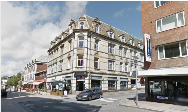
Figur 10: Tidligere bebyggelse på Nygaardsgata 32 før bygningen ble totalskadet i en brann
