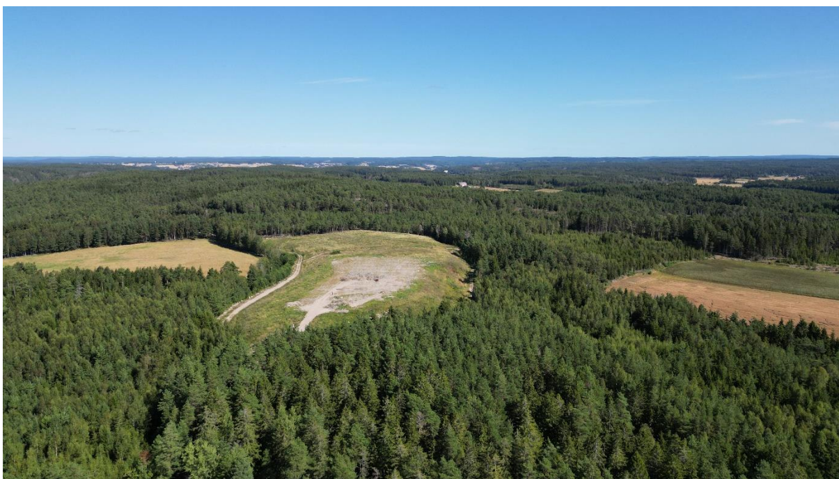
Figur 1-4 Forsetlundgropa sett fra sørvest (Jostein Thorvaldsen, Asplan Viak). Her ser man tydelig høydeforskjellen mellom massetaket og traktorveiene, spesielt veien mot sør (til høyre i bildet). Man ser også tydelig vegetasjonsbeltet mot sør.
