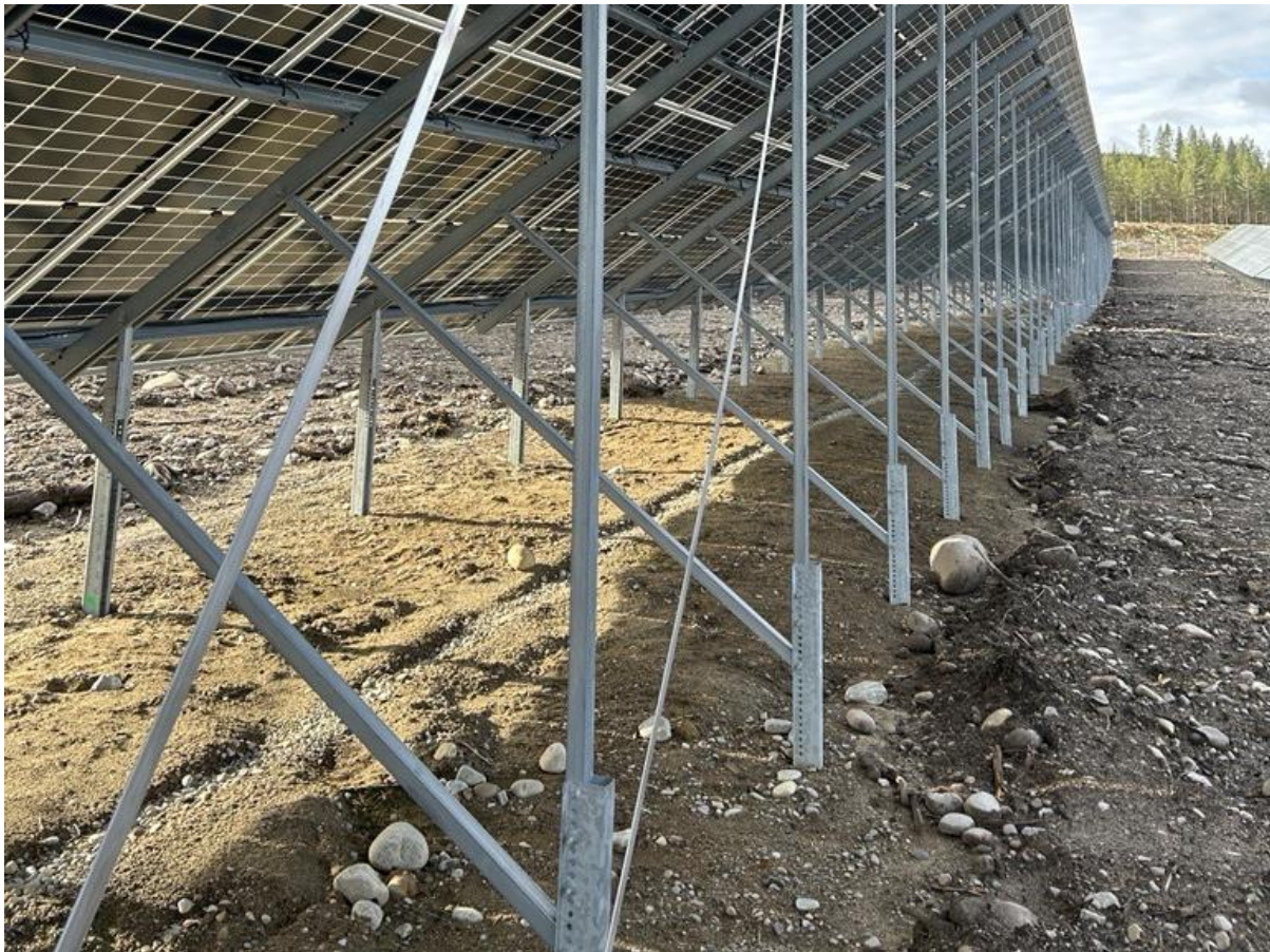
Figur 5: Bilde som viser peling som fundamenteringsmetode. Pelene går 1,5-2 meter ned i bakken for å unngå frost. Bilde er tatt ved Furuseth Solkraftverk i forbindelse med åpningen i oktober 2024.
