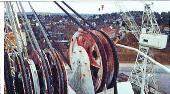
Skivesats topp A-ramme. Legg merke til hvor rustne wirene er. Wirene i mitten har en stål farge, det betyr at de er galvanisert.
