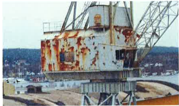
Wisbech-Refsum kran Bildet viser maskin hus.
