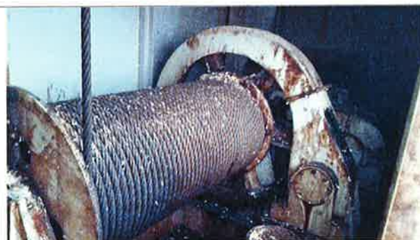
Bommheise (luffing) maskineri.
