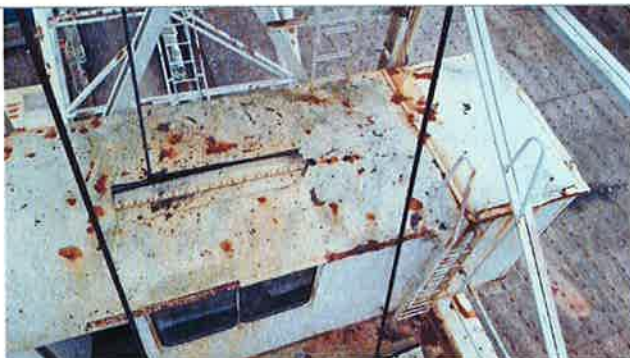
Tak over maskinhus/luffing hus.
