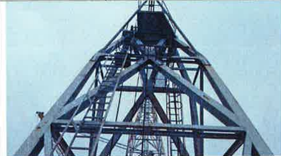
A-ramme på topp av maskinhus.
