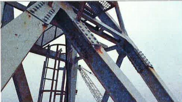
Bolt forbindelse A-ramme på tak av maskinhus.
