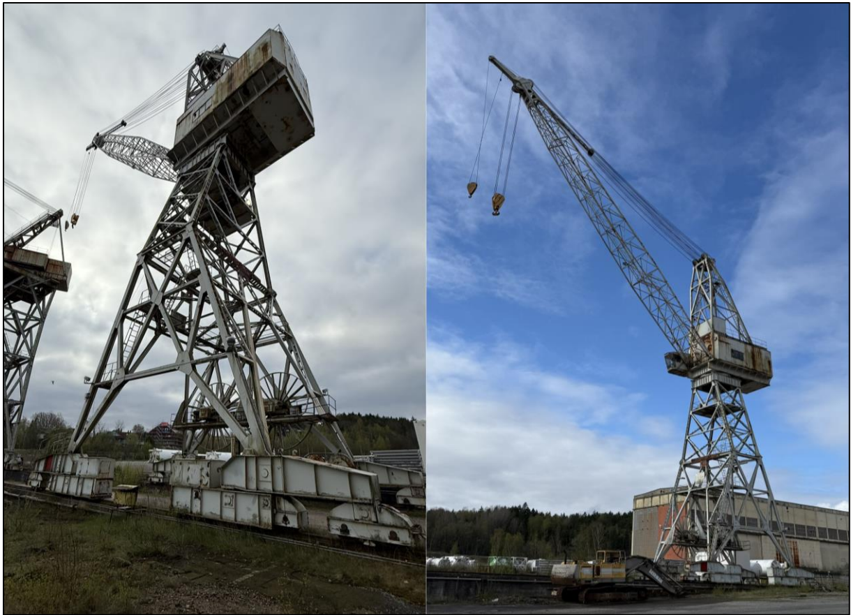
Figur 2-5 Fra befaring 23.04.25. Bilde av Wisbeck-Refsum-kranen
