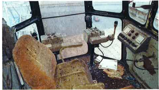
Fører kabinen. Ingen kontrollere og apparater virker.
