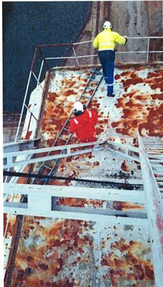
Wisbech-Refsum kran Tak på maskin hus.
