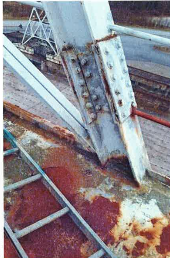
Skruforbindelse på topp av maskinhus.
