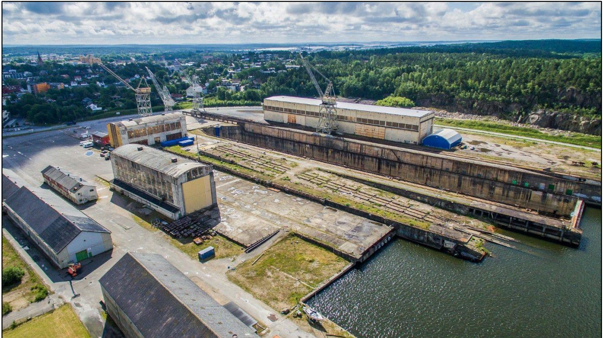
Figur 2-1 Dronebilde av Fredrikstad verft med dokka og kranene i bakgrunnen.
