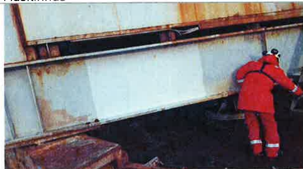
Nedre del maskinhus
