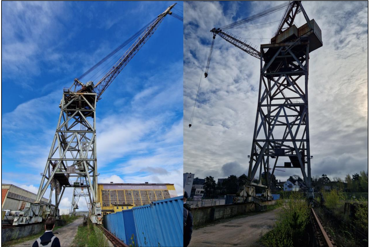
Figur 2-6 Fra befaring 23.04.25. Bilde av Washington T127-kranen
