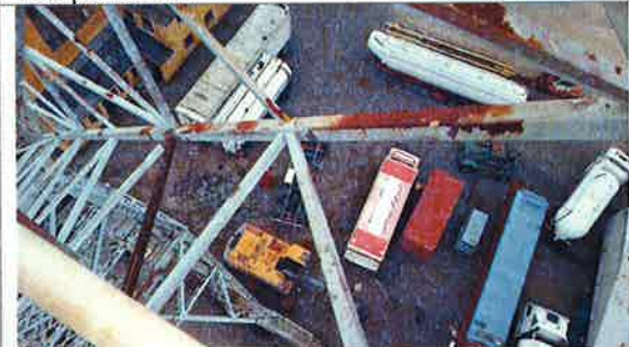
Detalj av bom. Typisk rust angrep
