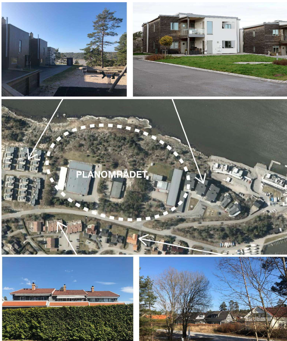
Figur 10. Bebyggelse omkring planområdet. Bebyggelsen i Måkeveien er i stor del skjult bak hekk og jordvoller mot Måkeveien.
