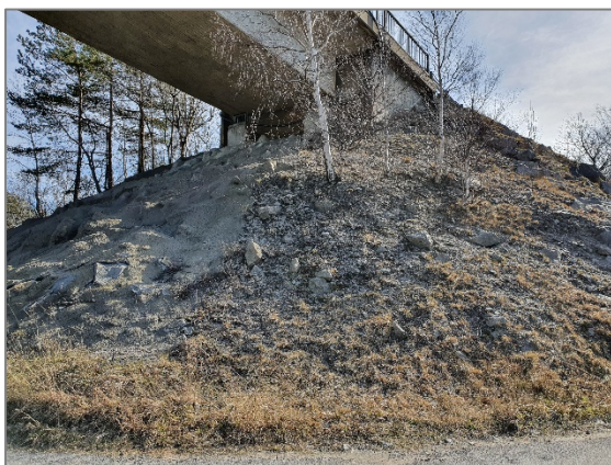
Figur 3: Bildene viser fyllinger under Kråkerøyveien. Sweco, 31. mars 2020
