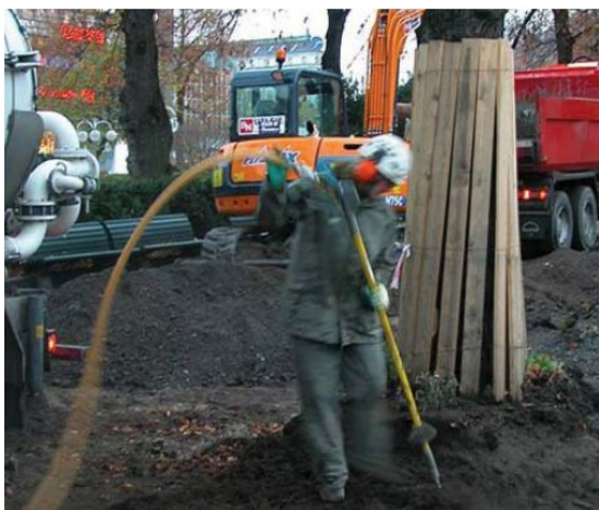
Figur 7: Illustrasjon på bruk av luftspade ved graving nær trær (3). ©Oslo kommune
