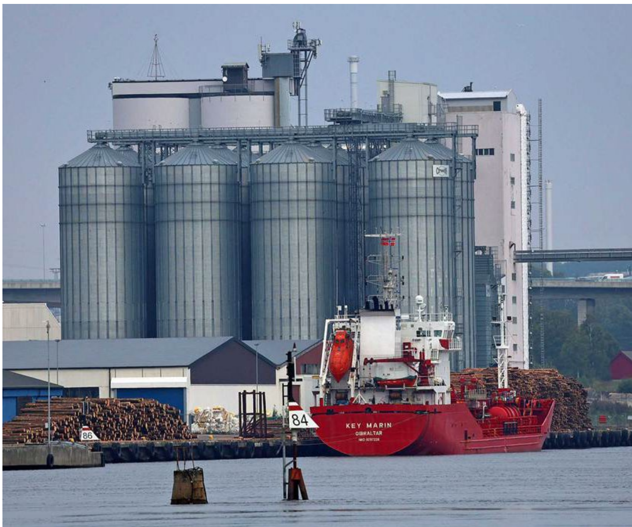
Alvimterminalen i Sarpsborg med siloanlegget til Felleskjøpet og Østfold korn. E6-brua over Glomma ved Sandesund vises i bakgrunnen. Foto: Ottar Nøkleby
