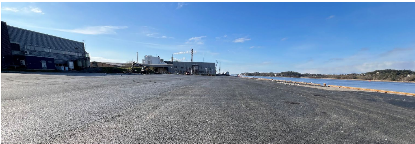
Havnelager 1 er revet og areal ferdig opparbeidet for kunde. Foto: Borg Havn IKS
