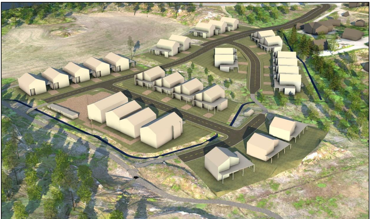
Figur 20: Boligprosjektet sett fra sydvest (In situ AS).
