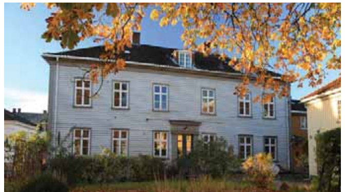
Binggården ble bygd opp etter en brann i 1830 og er en av Gamlebyens største empirehus i tre. Foto: LOK.
