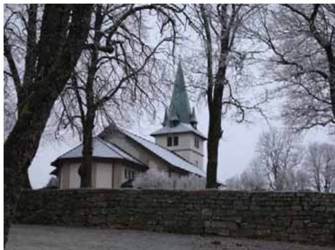
Onsøy kirke er tegnet av arkitekt Henrik Thrup-Meyer og ble oppført i 1877, på samme sted som den gamle middelalderkirken sto. Kirken er listeført av Riksantikvaren. Middelalderkirkegården, nærmest kirkebygget, er automatisk fredet. Foto: LOK.
