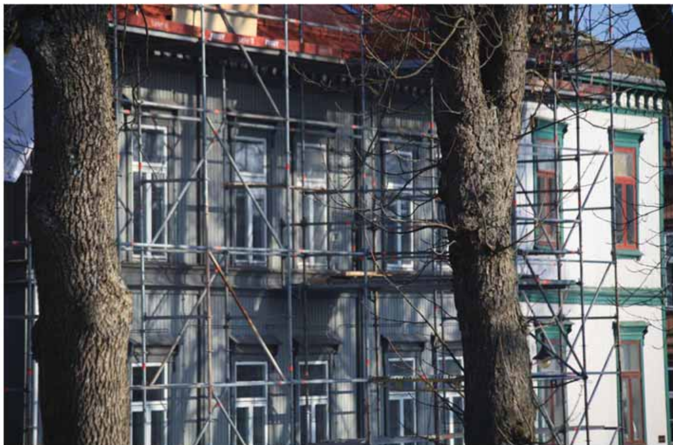
Bygård i Gamlebyen under restaurering. Mest mulig autentiske detaljer, materialer og farger er viktig i et slikt kulturmiljø. Foto: LOK.
