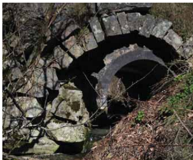
Stenhvelvsbru ved Fosse i Onsøy. Foto: LOK.
