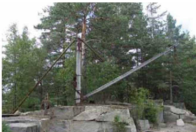
En av få gjenværende stenhoggerkraner finnes i Daleåsen i Holmsfjella i Torsnes. Foto: LOK.
