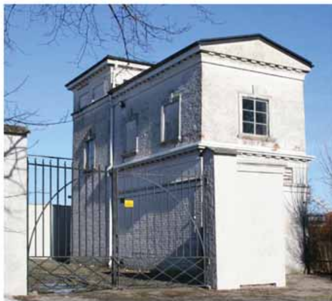
Trafo på Gudeberg i historisme. Foto: LOK.
