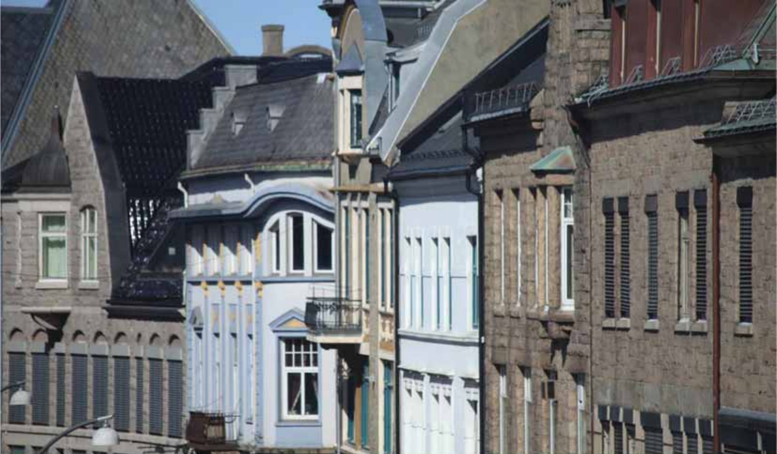
Jugendstilskvartalene nord for Stortorvet så dagens lys etter en større bybrann i 1908. Den arkitektoniske helheten har gjort at kvartalene er definert som et NBI-område av Riksantikvaren, det vil si at det er et historisk bymiljø av nasjonal interesse. Fasadene preges av råkopp granitt, svungne linjer og detaljerte utsmykninger. Foto: LOK.
