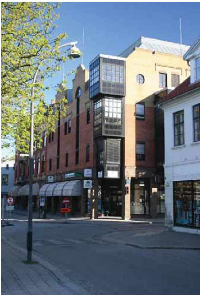
Storgata 10, oppført 1987, er et av byens mest karakteristiske postmodernistiske bygg. Det er tegnet av Koppen, Ludvigsen og Norvall arkitekter, med nytolkninger av de historiske fasadene til nabobyggene i jugend- og funkisstil. Foto: LOK.
