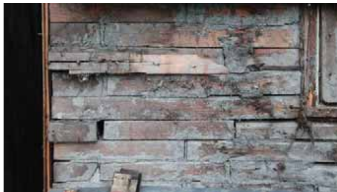
Knubb: plankeavkapp murt med leire og sagmøle på samme måte som mursten i forband. Foto: LOK.
