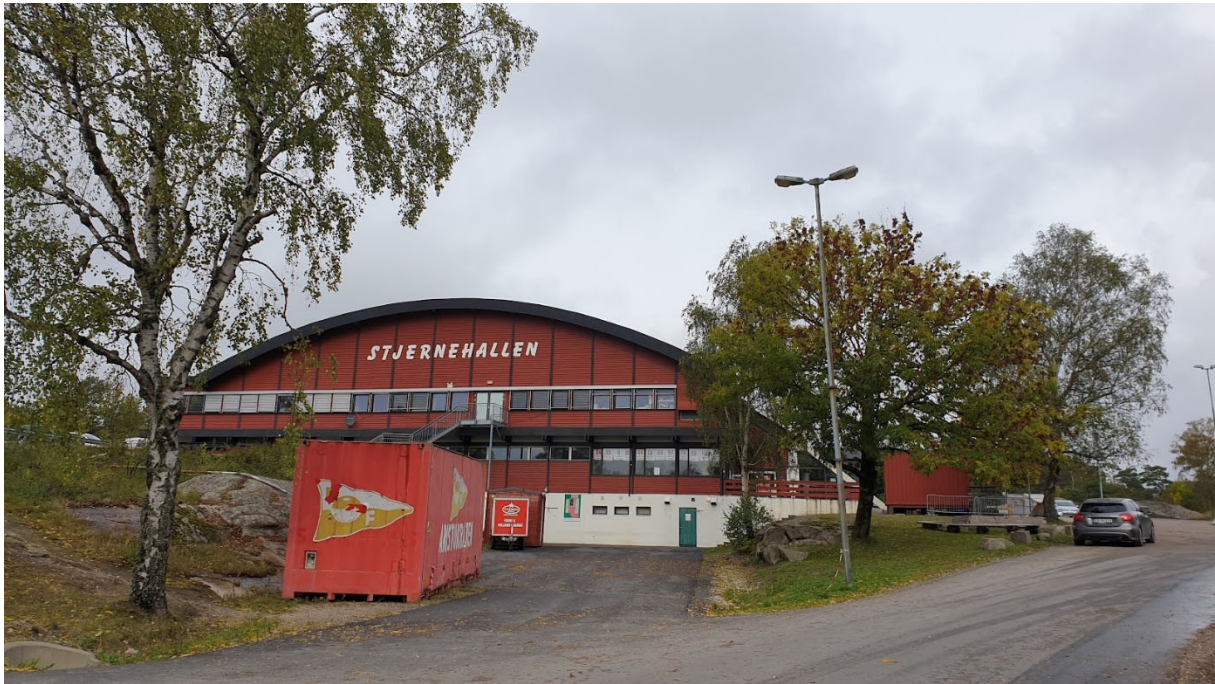
Bilde 2. Stjernehallen sett fra sør, med noen av de større trærne. Deriblant en stor ask (EN) nesten helt til høyre i bildet.
