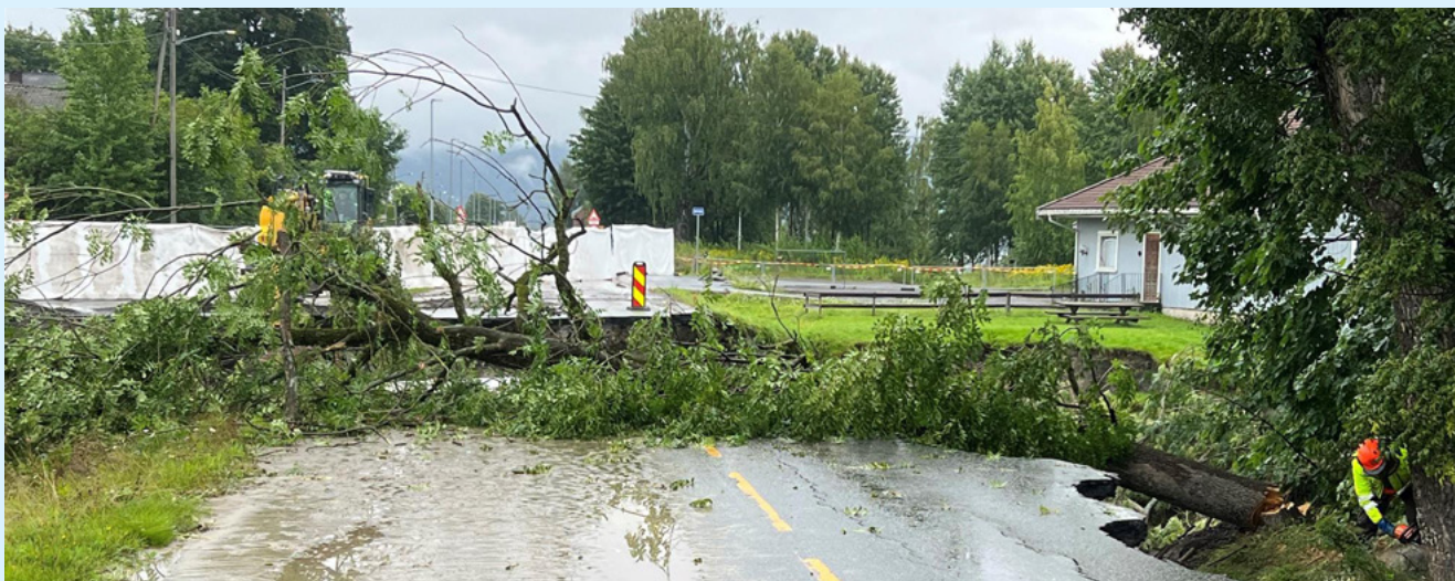
Ekstremværet Hans førte til oversvømte veier, skred og tusenvis av innbyggere evakuert på få timer. Ringerike er en av flere kommuner som har tatt lærdom. (Foto: Viken fylkeskommune)
