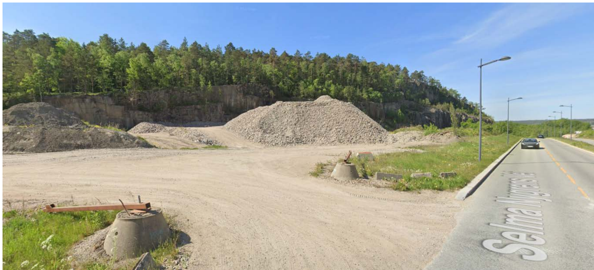
Figur 2.4: Planområdet sett fra Selma Nygrens vei mot skjæringen og Åsgårdfjellet.
