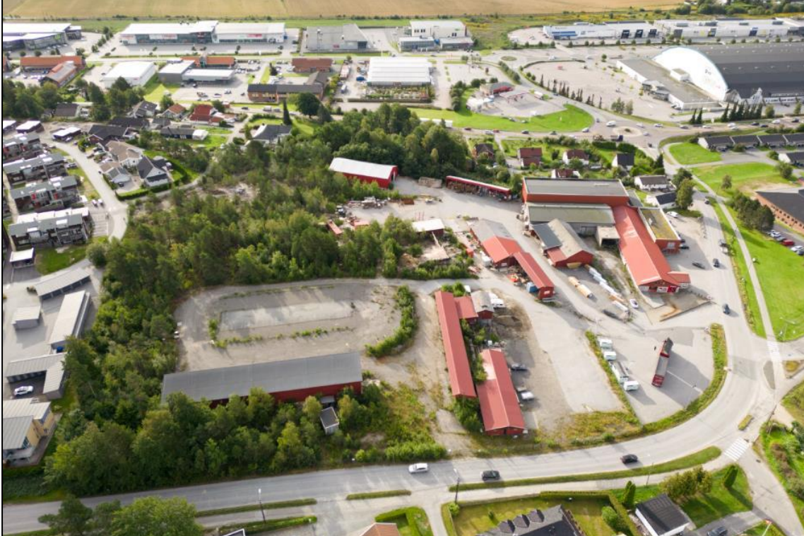
Figur 12. Planområdet i dag, sett fra nord. Planområdet er omkranset av vei og eksisterende boligbebyggelse.
