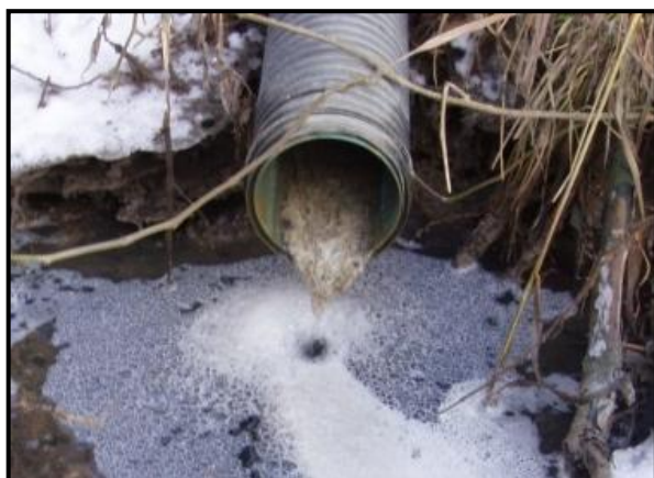
Figur 1. Et utslippspunkt for avløpsvann med for høyt innhold av organisk stoff
